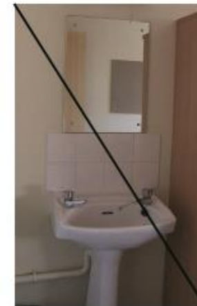
Плохо Раковина с пьедесталом. Фартук из плитки
